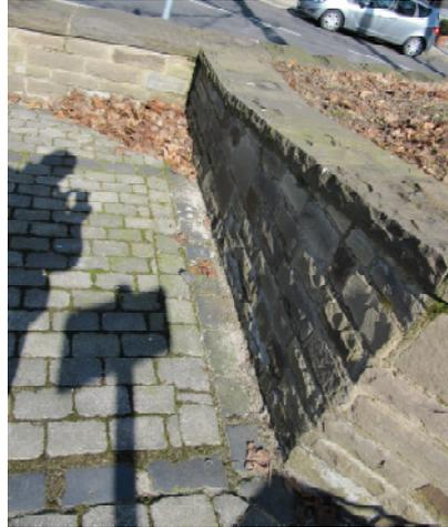
Ansicht der hangseitigen Stützmauer vor der Sanierung (Neuverfugung)
