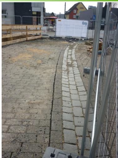
Behebung der Schäden in den Bereichen, in denen keine Erneuerung der Oberfläche erfolgt, wird dann erfolgen, wenn der Verbau gezogen wird. Dies geschieht nach Bau der Decke Tiefgarage in rund 10 Wochen (Ende Juni / Anfang Juli geplant).
