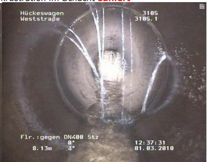
Photo 6 undichte Muffe **saniert**
