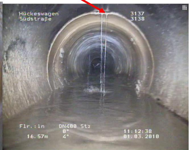
Photo 2 undichte Muffe (3137) **saniert**
