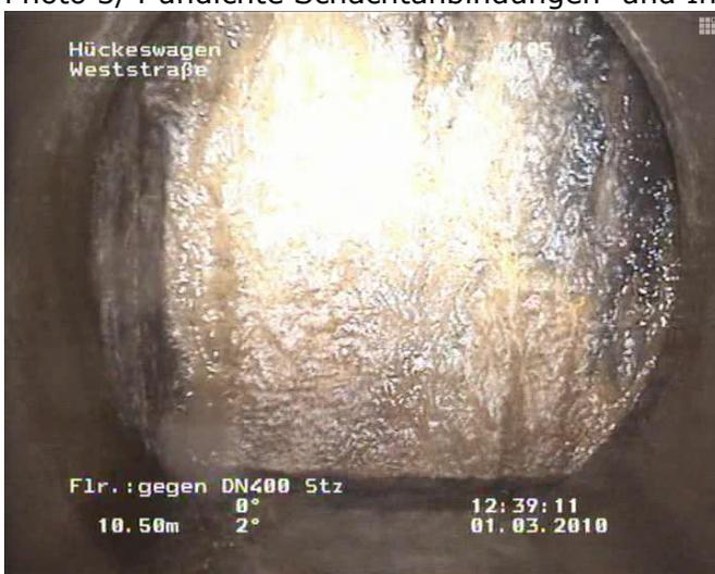
Photo 5 undichtes Endstück (3105)
