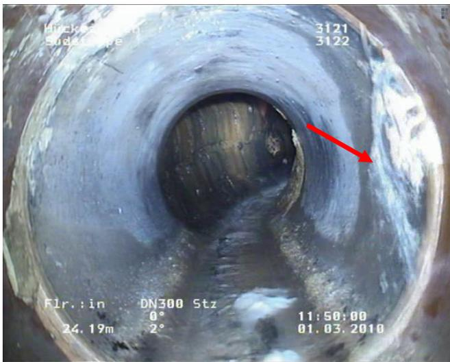
Photo 1 undichte Muffe **saniert**
