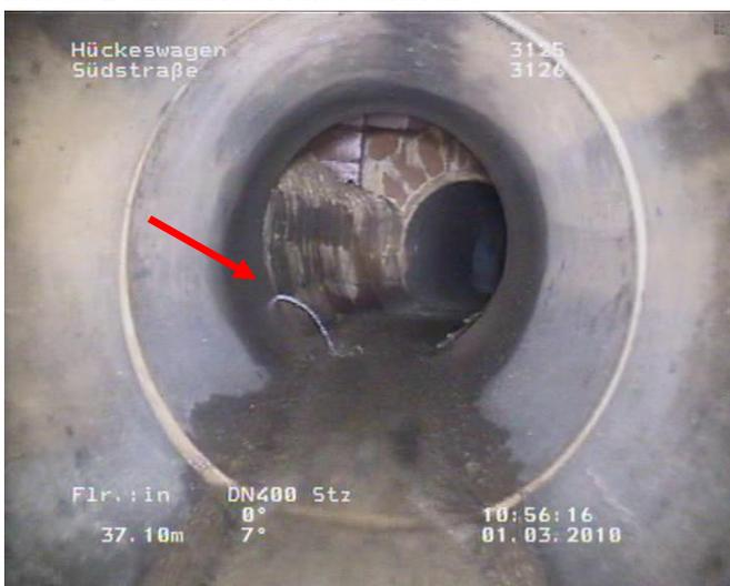
Photo 3/4 undichte Schachthanbindungen und Inkrustation im Schacht **saniert**
