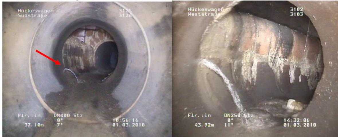
Photo 3/4 undichte Schachtanbindungen und Inkrustation im Schacht **saniert**
