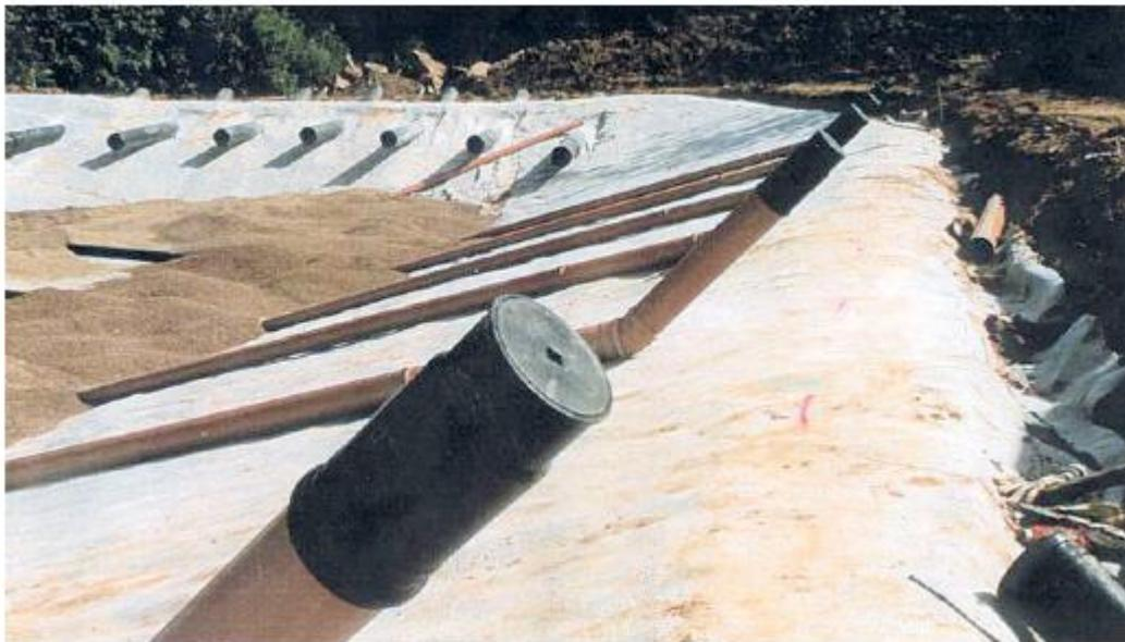
Abbildung 13: Inspektionsöffnung (Bild 5.11 aus dem Retentionsbodenfilterhandbuch)
