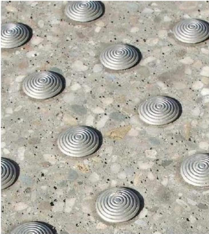
aufgeschraubte Stahlnoppen in geplanten Asphalt- bzw. Pflasterbelag
