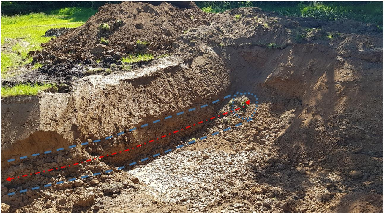
Abbildung 7      Mutmaßlicher Verlauf des Stollens, Grobstrukturen / Verfüllmaterial erkennbar, Knick Richtung Süden
