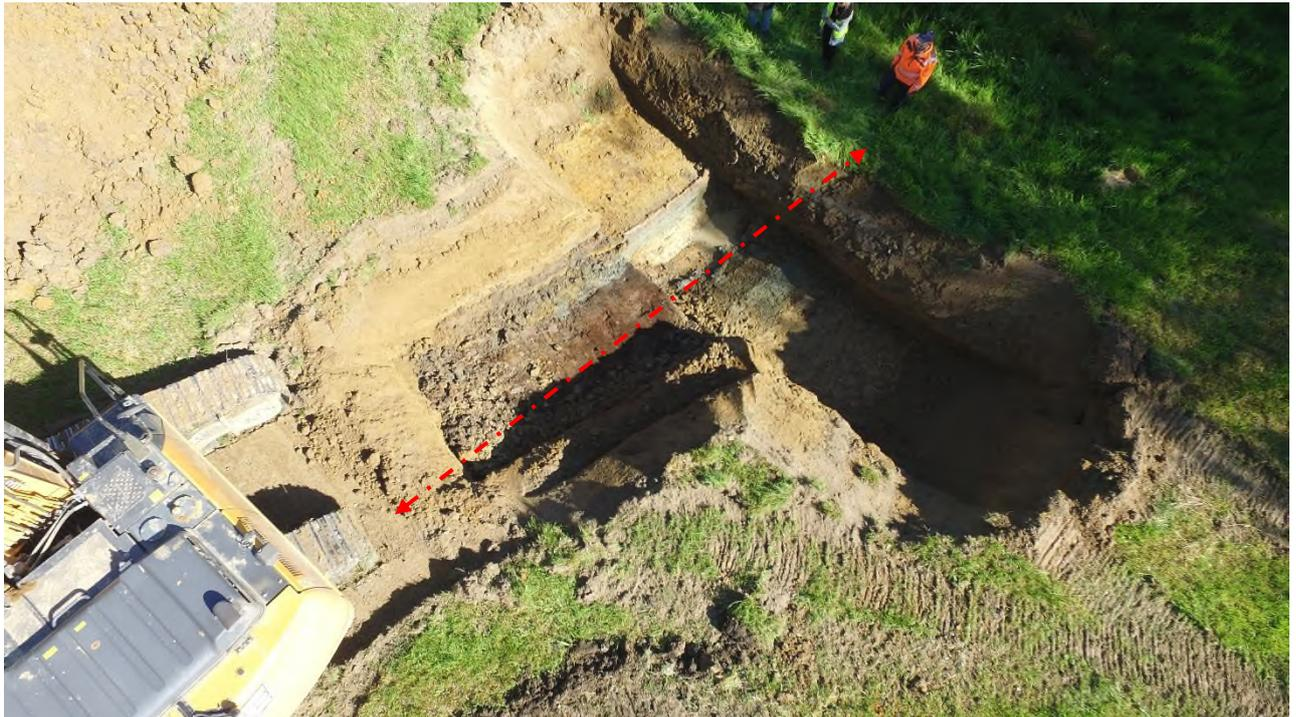
Abbildung 6      Detailansicht aufgegrabener Röschenverlauf
