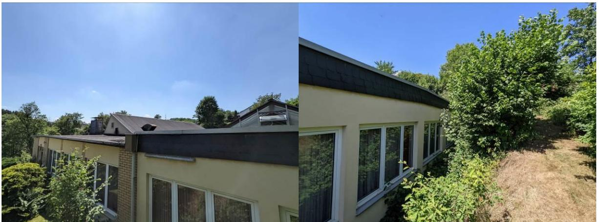
**Bild 8a-b:** Fotos der Dach- und Fassadenbereiche (Blechatika und Schindelverkleidung)
