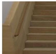
Holz - Treppenwangen/ - geländer Tritt- und Setzstufenbelag aus Eiche Tragkonstruktion Treppe Stahlbeton
