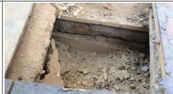
Holzdielen mit Schalung auf Holz balken, Ausfachung mit Lehm, Holz balken geschädigt und unterseitig mit zusätzlichem Balken verstärkt
