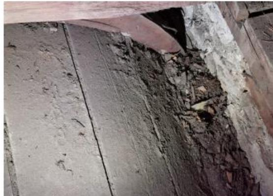
Abb. 4: Detailfoto von Abb. 3. Konstruktion der gebogenen Deckenkehle mit Längsbrett. Der Anschluss Mauerwerk / Deckenbalken erfolgt über eine bogenförmige Holzschiene.
