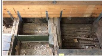
Holzbalken seitlich geschwächt und mit Bolzen + Ankern an Verstärkungsbalken (Brettschichtholz) befestigt, Einschub links mit Heraklithplatte, rechts Schwartenhölzer mit Schutt
