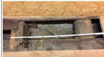
Laminat auf Holzdielen (Nutz + Feder), alte Holzdielen auf Holz balken, Balken links (Schnittholz) mit Schaden, Balken rechts (mit Waldkante) älter
