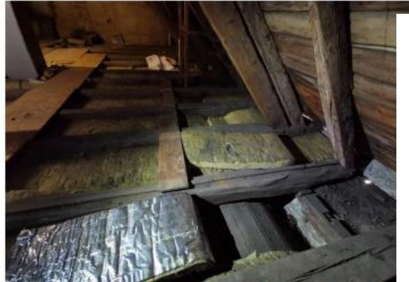
Abb. 3: Übersichtsfoto Dachgeschoss mit Konstruktion der historischen Balkendecke ne hölzerner Bogenkonstruktion der Deckenkehle.
