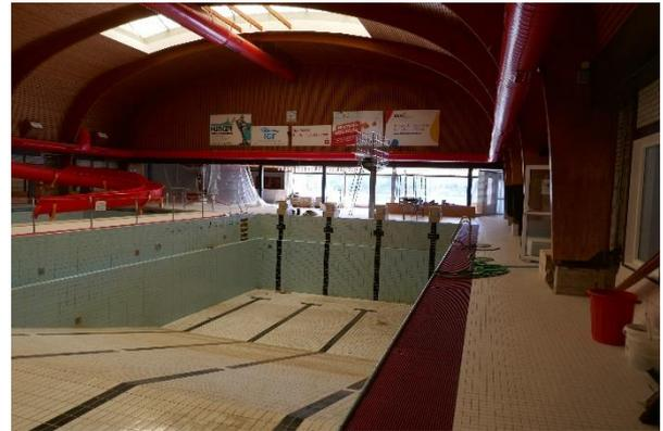
Abbildung 24: Tonnendach mit Oberlichtern
