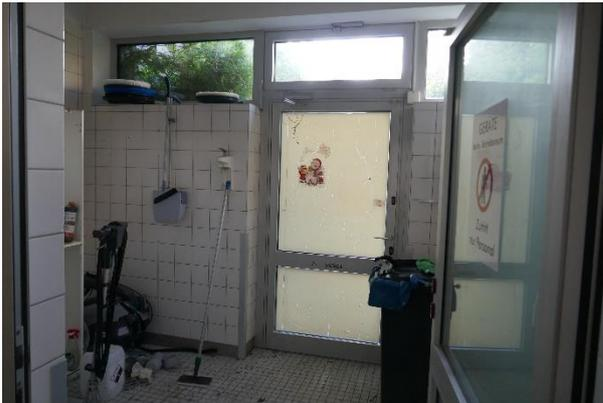
**Abbildung 33: Türanlage mit Aluminiumrahmen**
