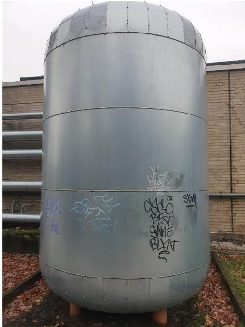
**Abbildung 72 Pufferspeicher für das BHKW im Außenbereich**
