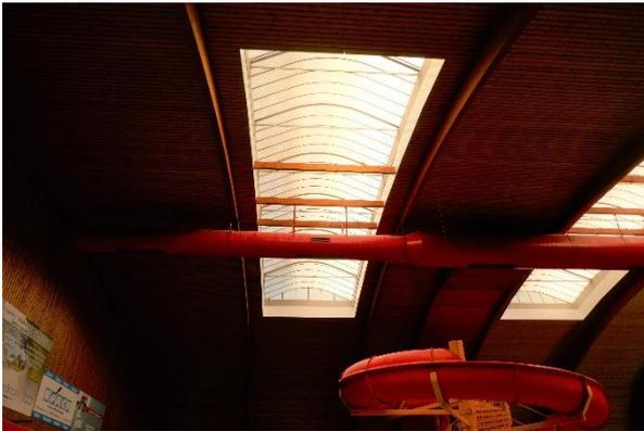
Abbildung 42: Grill-Lichtbänder im Tonnendach
