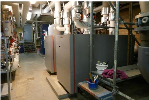
**Abbildung 13: Spitzlastkessel für das Nahwärmenetz, die im Wechselbetrieb arbeiten**
