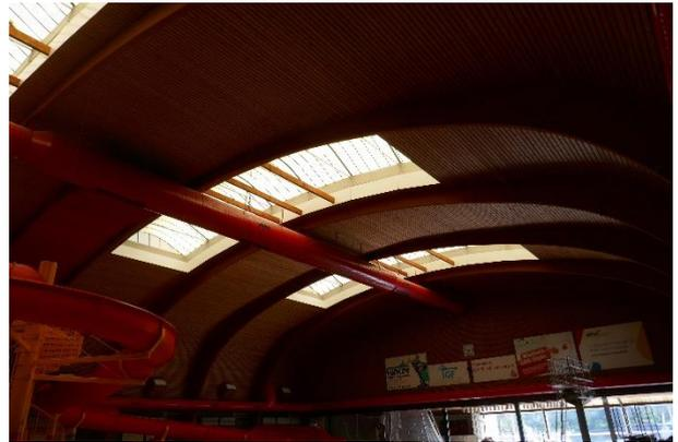
**Abbildung 10: Hallendach mit Oberlichtbändern aus Kunststoffs-Doppelstegplatten**
