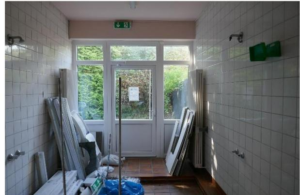
**Abbildung 34: Erneuerte Türanlage mit Kunststoffrahmen**
