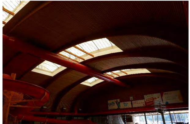
**Abbildung 10: Hallendach mit Oberlichtbändern aus Kunststoffs-Doppelstegplatten**
