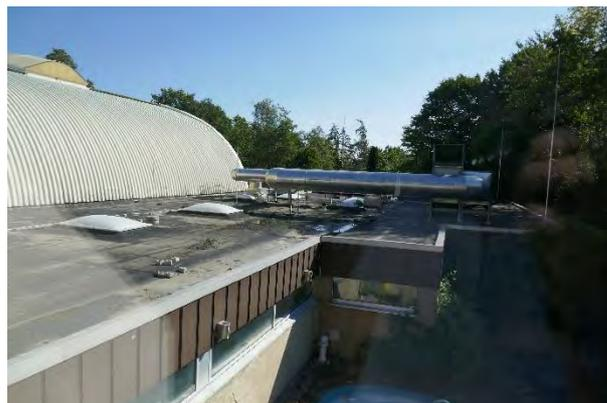
**Abbildung 6: Flach- und Tonnendach mit Lüftungsgerät**
