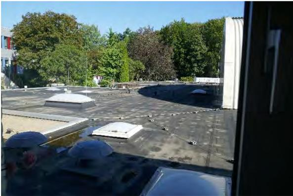
Abbildung 35: Dachabdichtung mit Kunststoffbahnen
