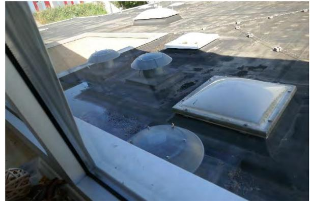
Abbildung 36: Einbauten und Durchdringungen
