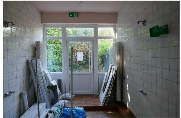
Abbildung 34: Erneuerte Türanlage mit Kunststoffrahmen
