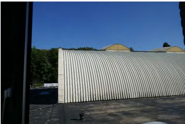
Abbildung 37: Tonnendach mit bombiertem Wellblech
