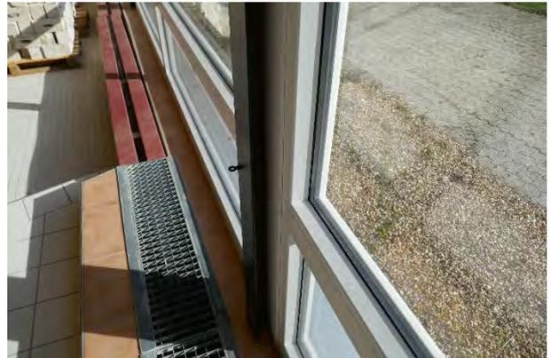
**Abbildung 30: Fenster mit Kunststoffrahmen zum Liegebereich**
