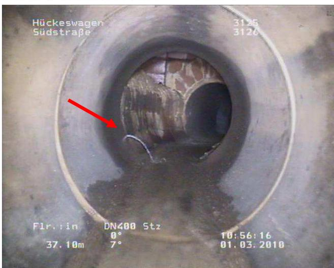
Photo 3/4 undichte Schachtanbindungen und Inkrustation im Schacht **saniert**
