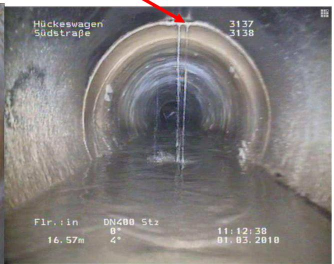
Photo 2 undichte Muffe (3137) **saniert**
