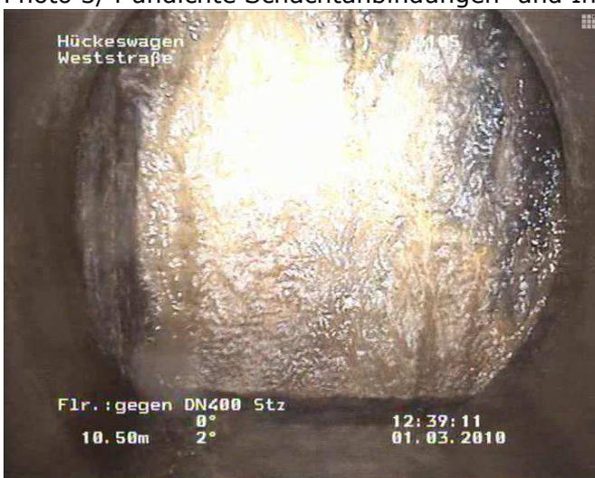
Photo 5 undichtes Endstück (3105.1) **saniert**
