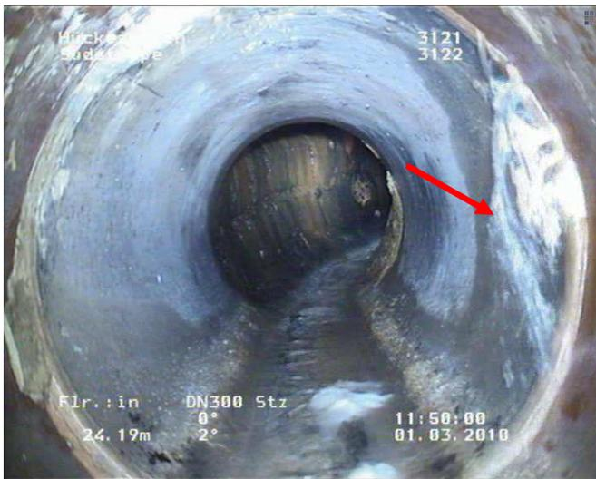
Photo 1 undichte Muffe **saniert**
