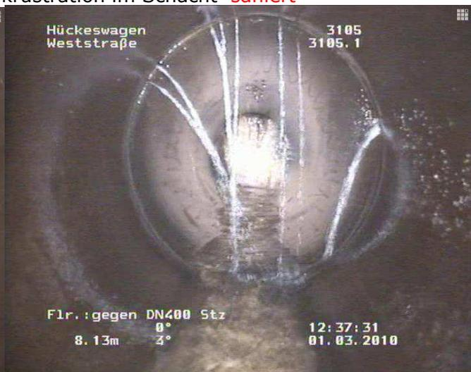
Photo 6 undichte Muffe **saniert**
